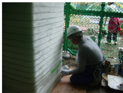
幼稚園補強工事中
