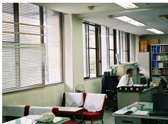
市役所補強工事中（中央の窓際柱）
