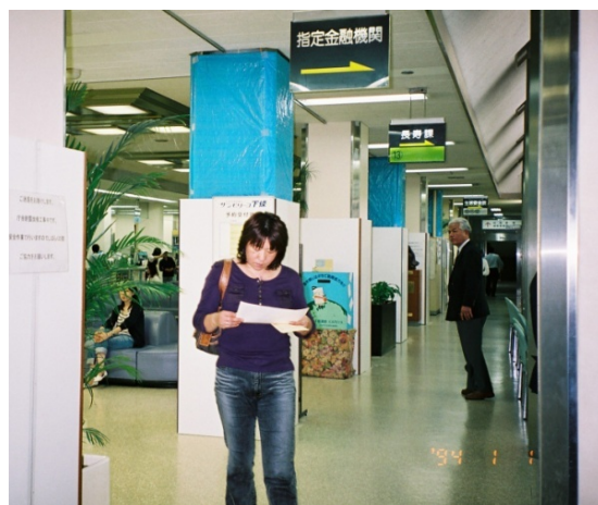
市役所補強工事中（中央の室内柱）
