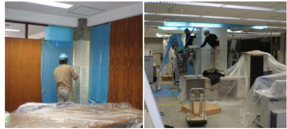
写真-11 SRF 補強工事の様子
