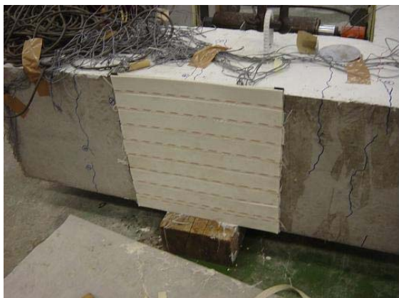
写真一五 鉄筋の欠損部にSRF補強した梁の実験 7)
