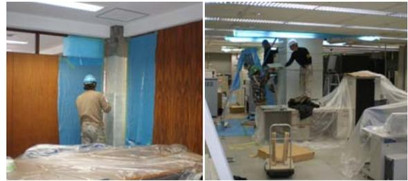
写真-11 SRF 補強工事の様子
