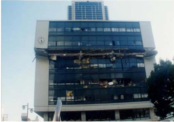
写真—1 2 阪神淡路大震災神戸市庁舎の被害
