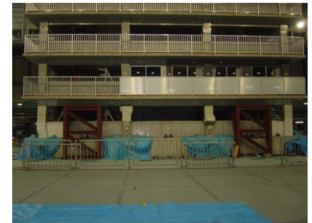
補強完了状況 4
