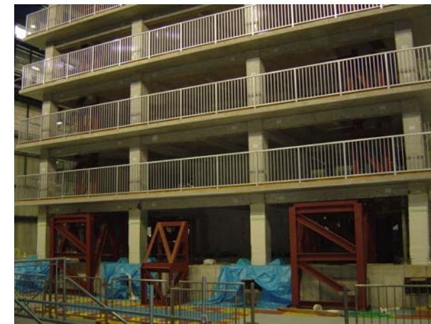
補強完了状況 3
