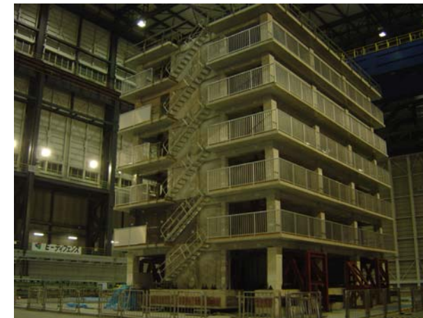
補強完了状況 1
