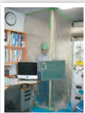
作業範囲を養生する
