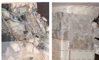
鉄筋コンクリート柱は、4波目で潰れました(左)。7波加振後にSRFの高延性材を剥がして柱内部を確認。ほとんど損傷がありませんでした(右)。
