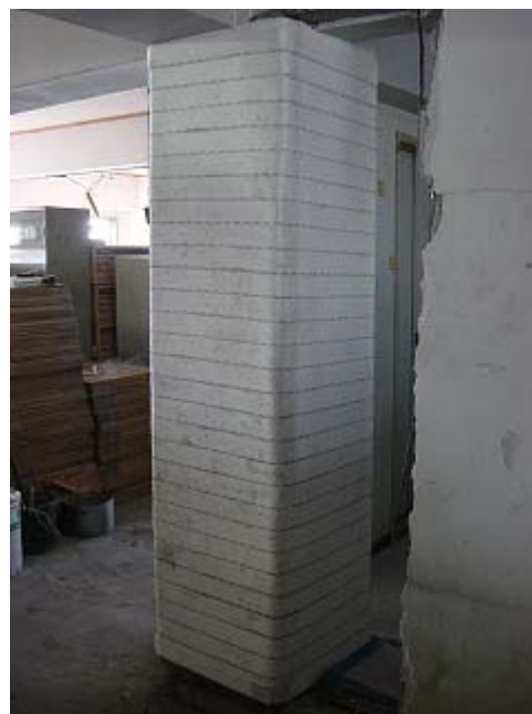
内部柱補強後
