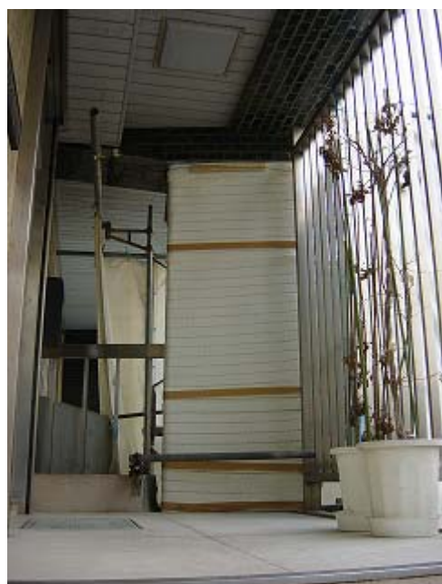
外部柱補強後
