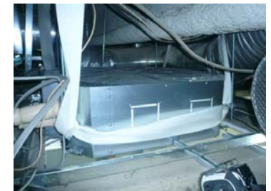
エアコン吊元部
